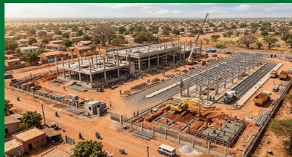
Projet de Réhabilitation du Marché Central et d'élévation
