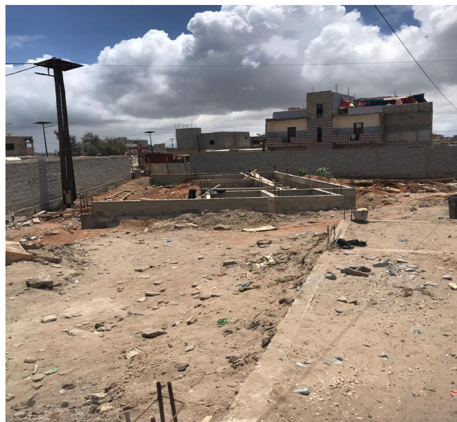
Travaux de construction du Centre de Formation Professionnelle de Pikine. Le niveau d'exécution des travaux n'est pas satisfaisant
