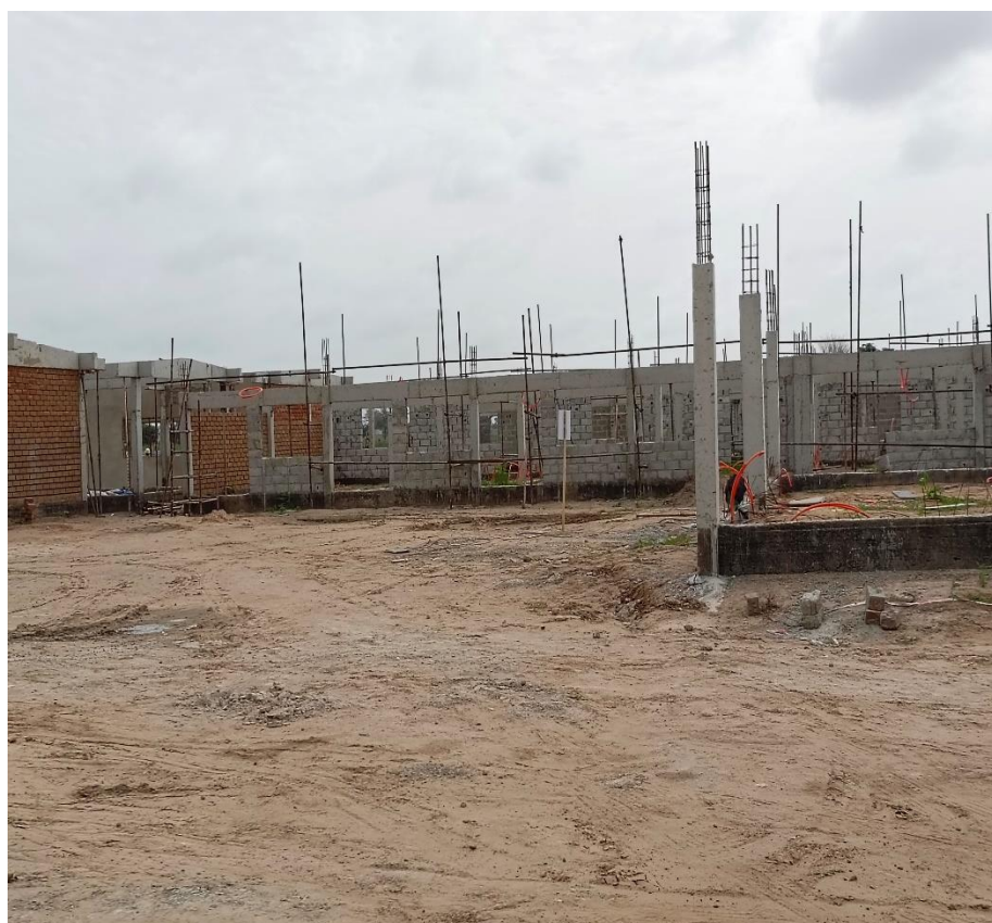
Travaux de construction du Centre de Formation Professionnelle de Diourbel
