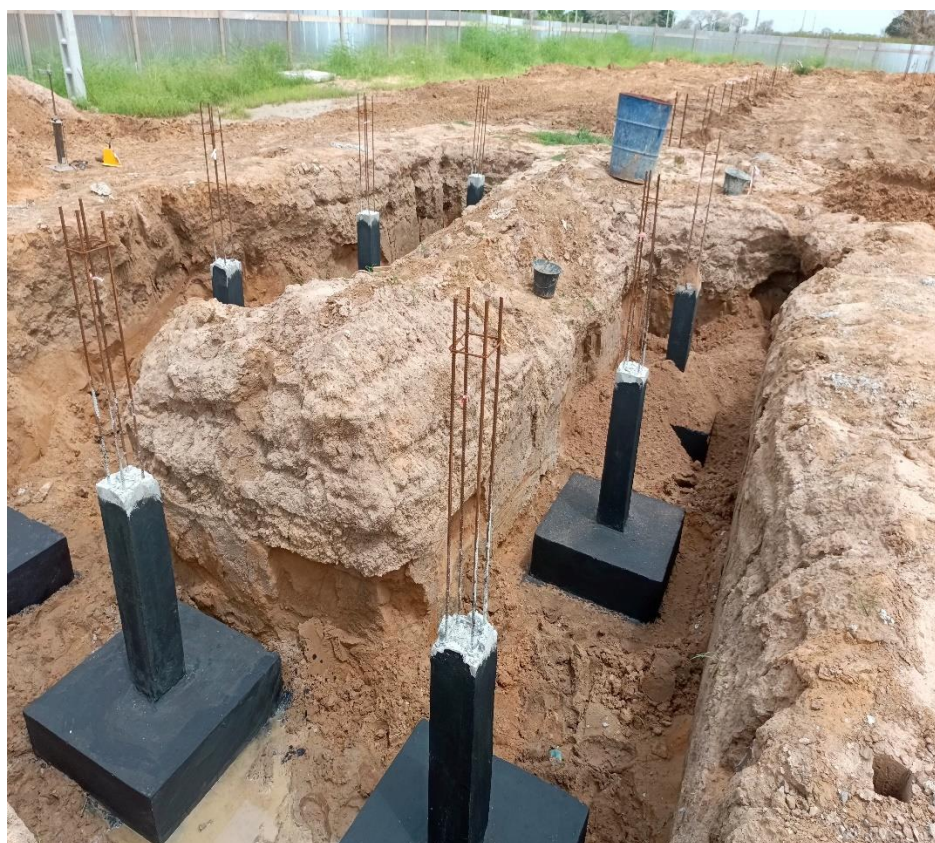
Travaux de construction du Centre de formation Professionnelle à Niakhar au stade de fondation
