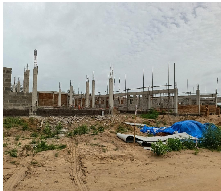
La mission a constaté que les Travaux du Centre de formation Professionnelle sont en cours de réalisation à Diourbel
