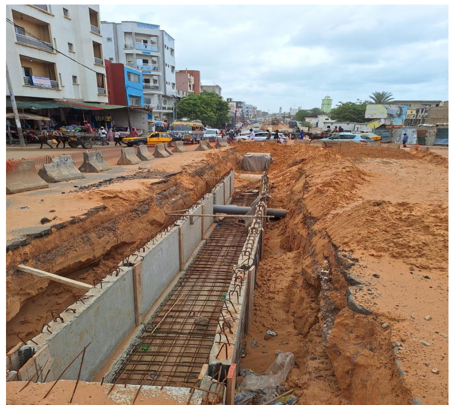
Canalisation des deux voies passant vers Rondpoint Case Baa
