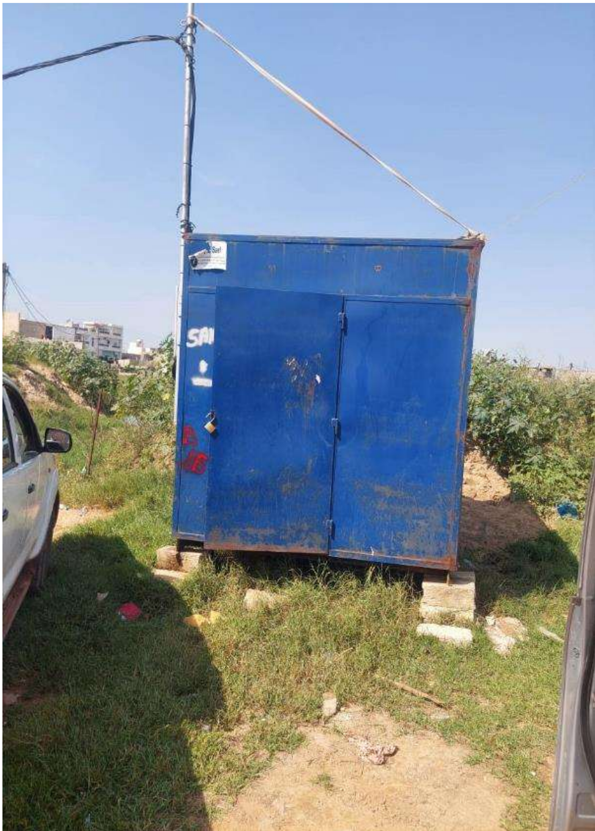
Image 3 : Conteneur de pompage
