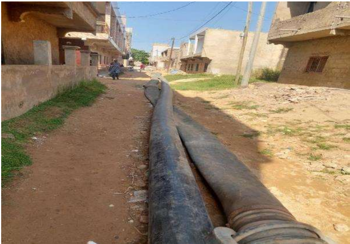
Image 8 : Tuyaux de déversement du bassin d'Amina vers le bassin du garage d'Aladji Pathé
