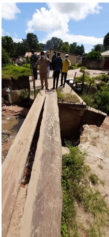
Pont de Badiankoto
