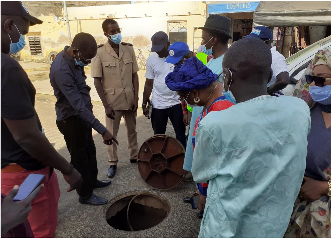
Photo 3 : commune de Medina Gounass/ un lit important de boue et de sable au fond du canal /les tuyaux qui évacuent les eaux dans le canal parfois bouchés par les eaux usées et des déchets solides.
