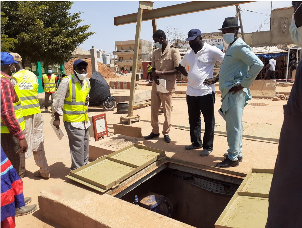
Photo : Station de pompage Axe Unité 1_ Unité 3 Boulevard Seydina Mandione Laye. Cet ouvrage vise principalement à améliorer la mobilité urbaine et renforcer le système d'assainissement des eaux pluviales Année : en cours (Exécutée à 98%)
