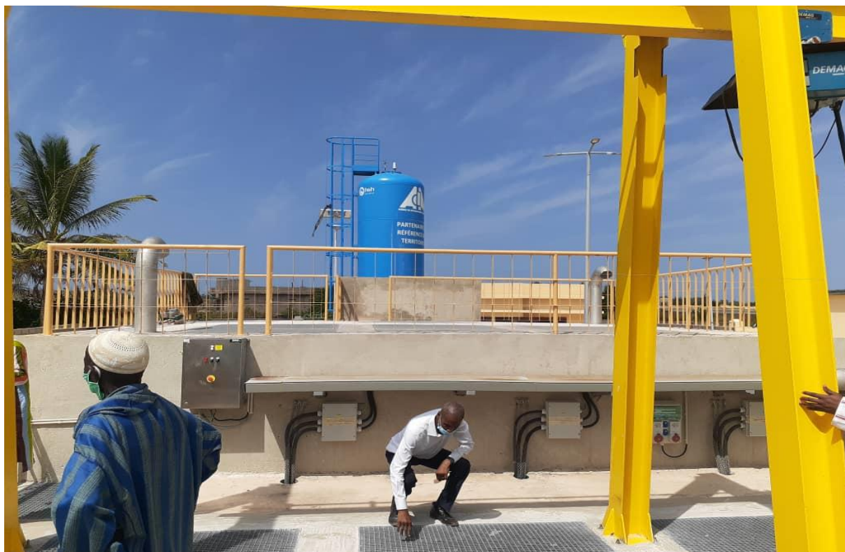
Station d'épuration de Mbeubeuss de la commune de Keur Massar réalisée par l'ADM dans le cadre du PROGEP 1
