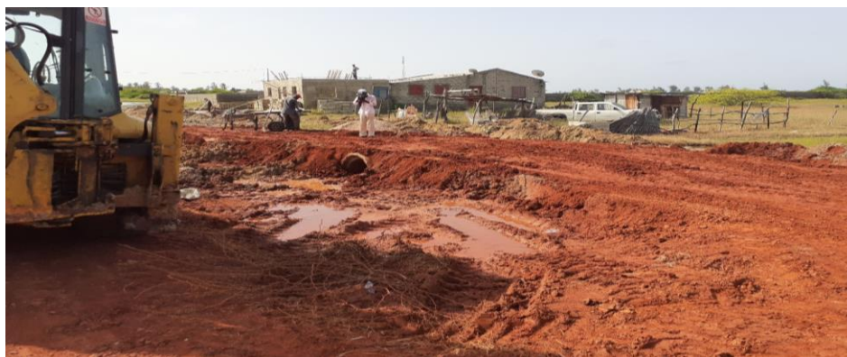
Photo : Construction d'une buse à Palmarin pour l'évacuation des eaux pluviales en passant sous la route et aller vers les déversoirs/ Plan Orsec
