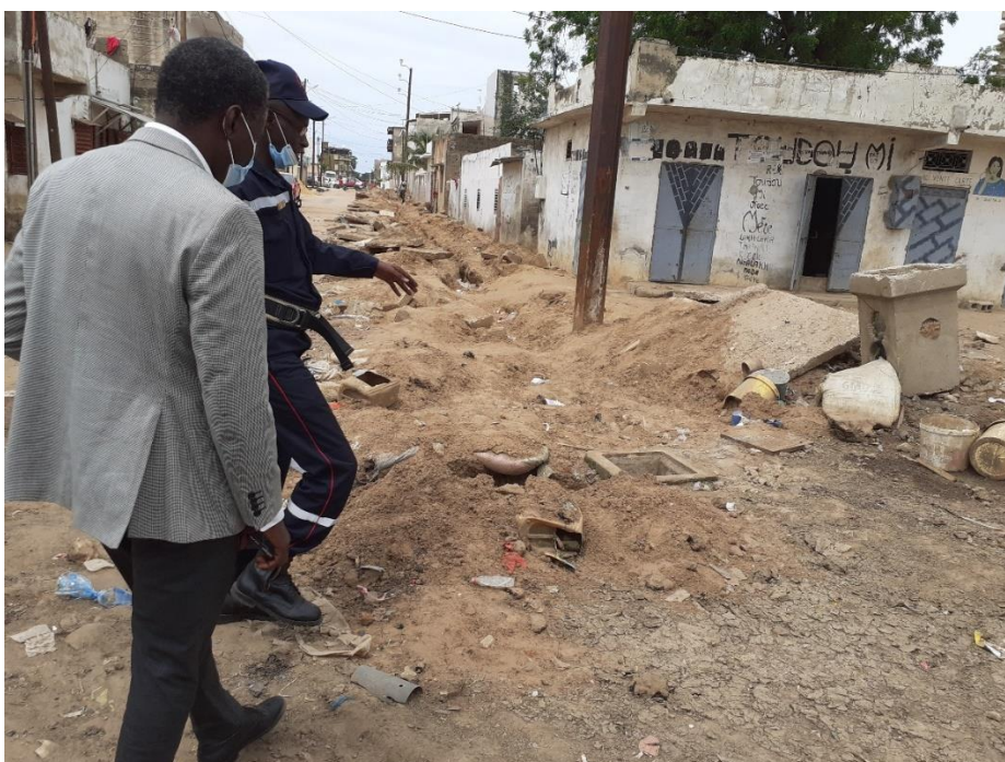
Photo : Kouly Poste courant/ commune de Tivaoune raccordement à l'ancien réseau d'assainissement à titre provisoire, travaux effectués par la mairie.
