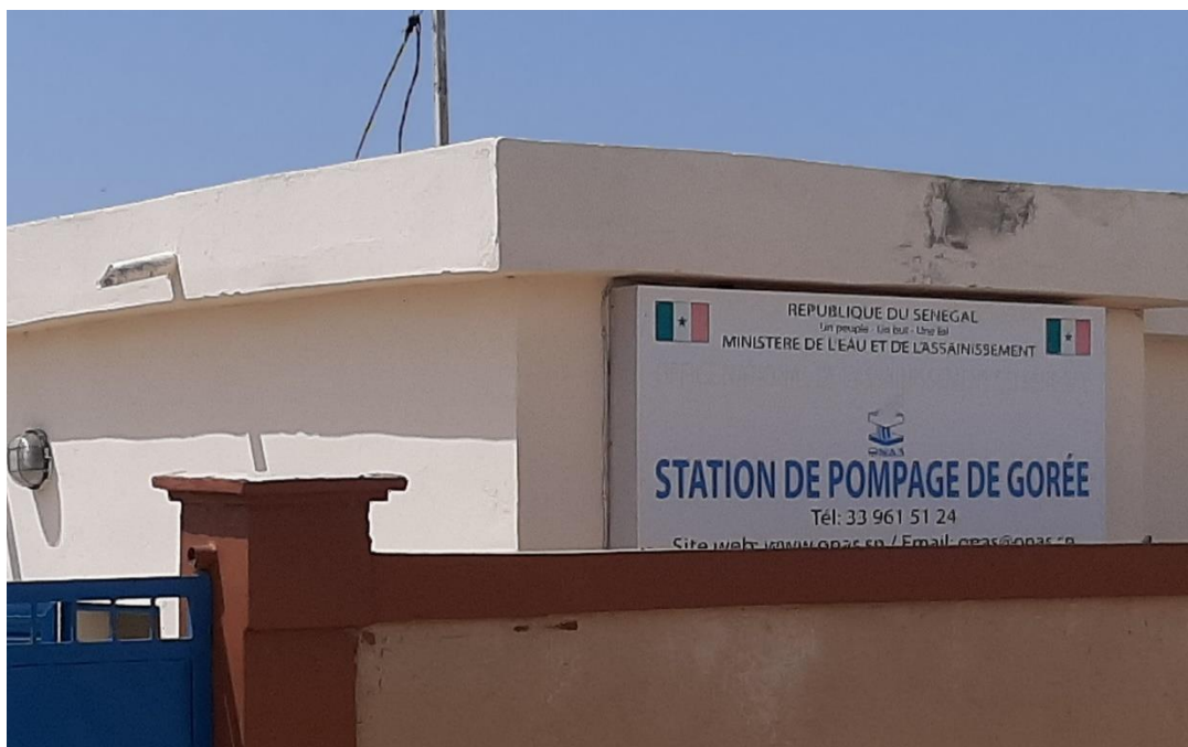
Station de Pompage de Gorée
