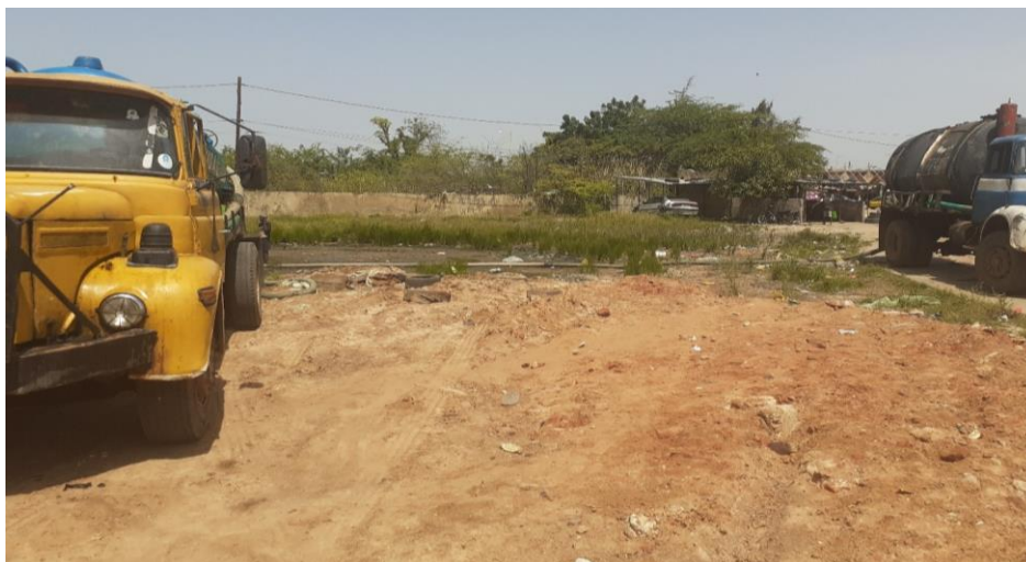
Photo : devanture Gare routière de Fatick, remblai d'un point bas qui est inondé à chaque grande pluie/ plan Orsec
