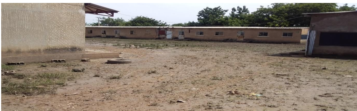
Ecole 5 de Diamagueune Centre est une zone inondable du fait qu'il est le point le plus de la commune. Il est recommandé de la délocaliser pour y ériger un bassin de rétention.
