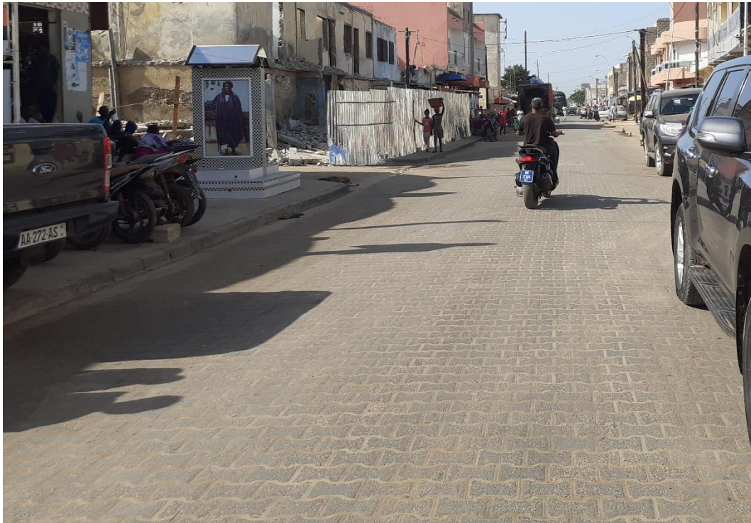
Photo 1 : Commune de Médina Gounass/ canal souterrain d'évacuation des eaux pluviales et revêtement en pavée de la route réalisés dans le cadre du PROGEP
