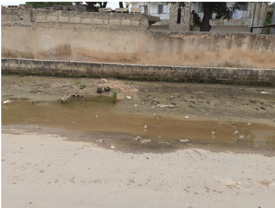
Photo : Quartier Fogny/ Commune de Tivaoune, les eaux évacuées après pompage exécutoire proche
