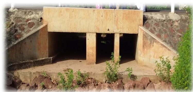
Ouvrage de franchissement d'eau sur la RN7 communale
