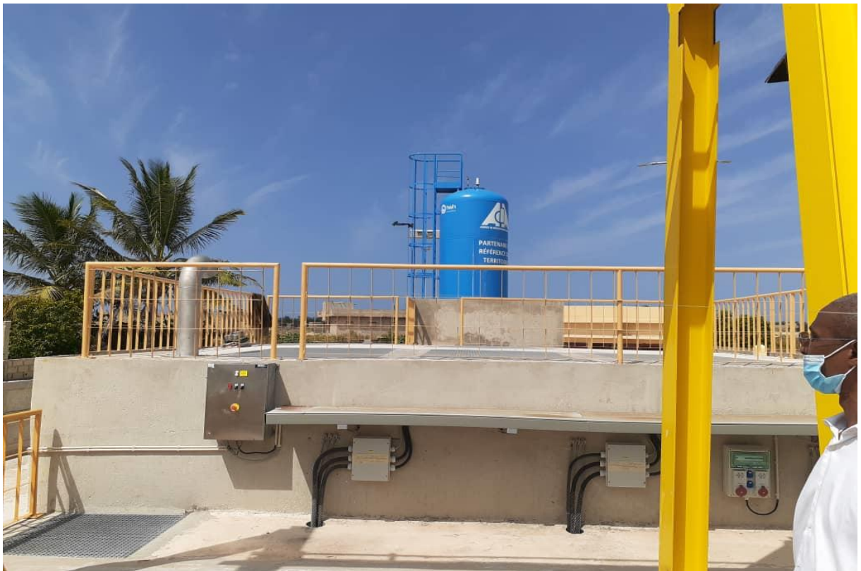
Station d'épuration de Mbeubeuss de la commune de Keur Massar réalisée par l'ADM dans le cadre du PROGEPI
