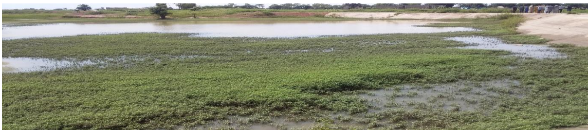
Digue construite en 2013, située au niveau de la route de Kounghoul (rond-point dakharga) dans le quartier Diamagueune Ndiobène de la commune de Fatick.
