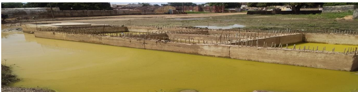
Station de pompage en cours de réalisation par l'ONAS. Les travaux sont exécutés par l'entreprise CSTP (PDLI).
