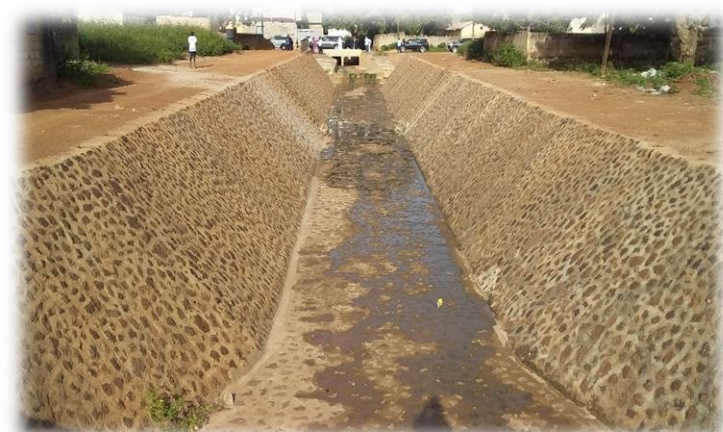
Grand canal d'évacuation des eaux pluviales jusqu'à l'exutoire de Porokhane
