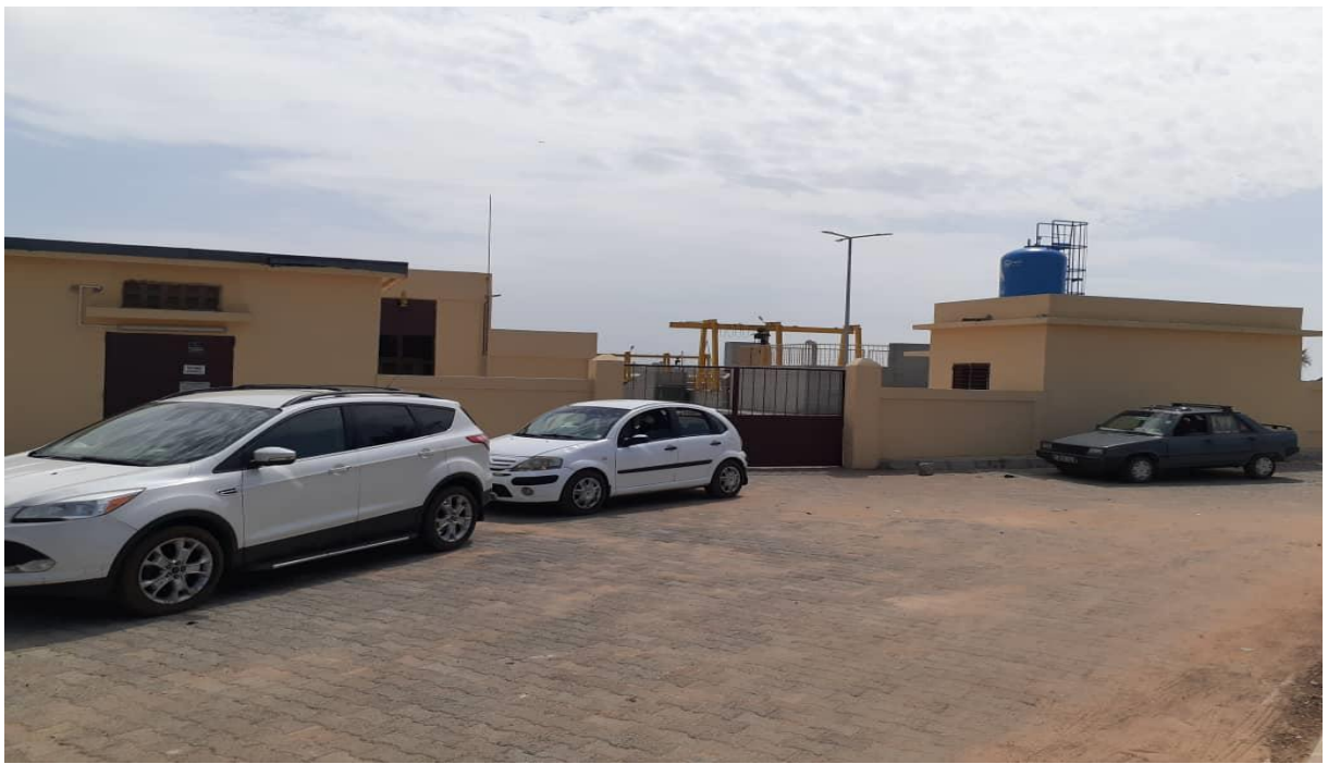
Station d'épuration de Mbeubeuss de la commune de Keur Massar réalisée par l'ADM dans le cadre du PROGEPI
