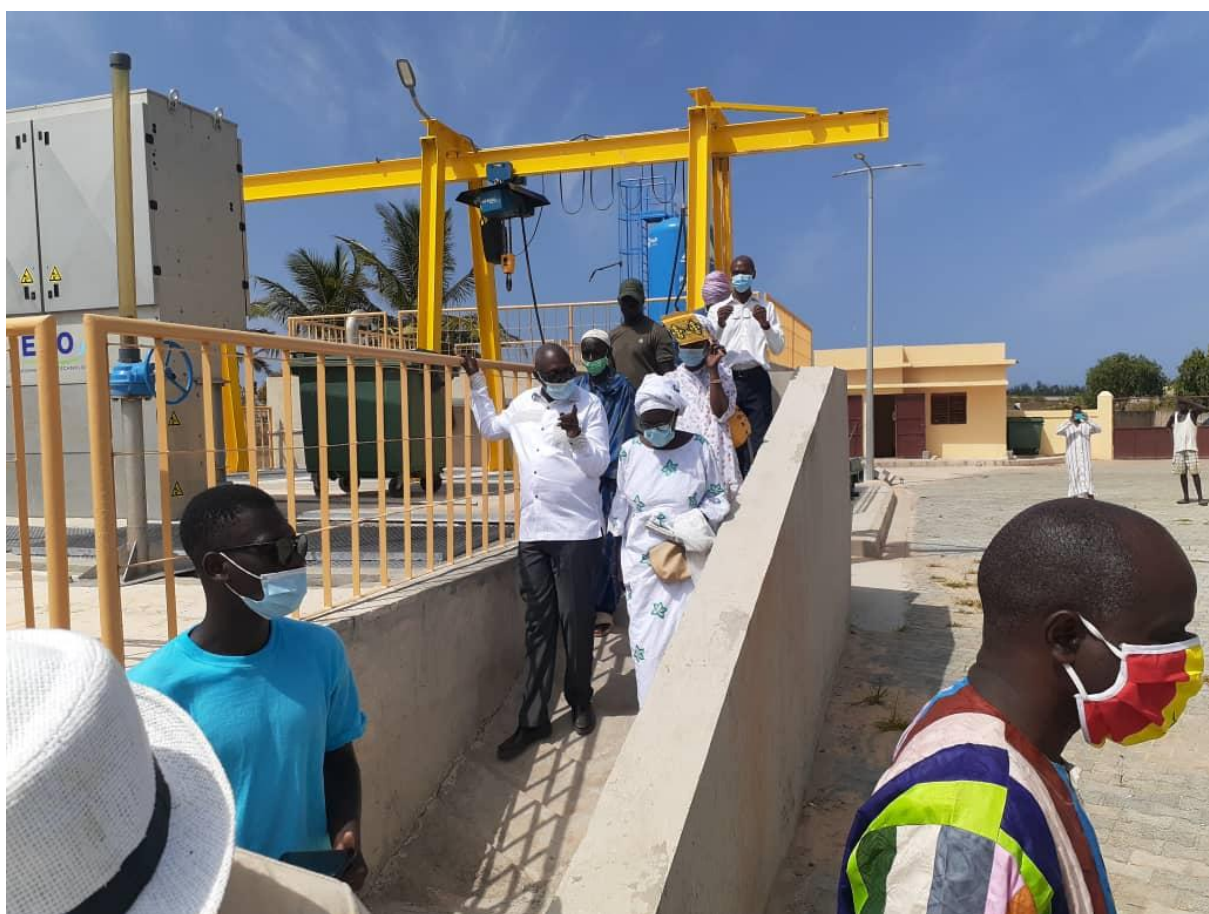
Station d'épuration de Mbeubeuss de la commune de Keur Massar réalisée par l'ADM dans le cadre du PROGEPI
