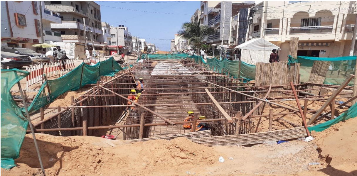
Photo : Cité Douanes : réalisation de volet assainissement-drainage des eaux dans le cadre de l'exécution du Projet BRT. Canal souterrain qui relie la Pharmacie Golf à la VDN
