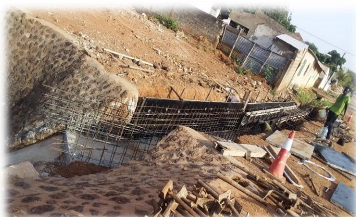
Finition des travaux de raccordement
