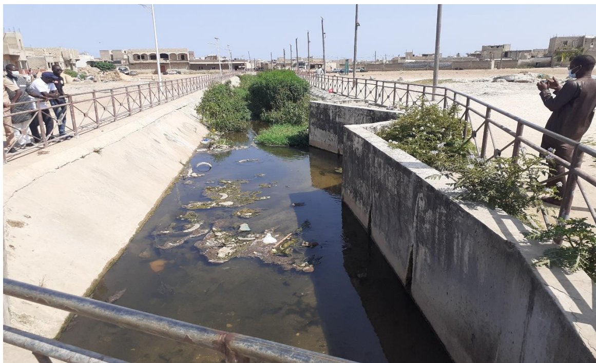
Photo : Canal à ciel ouvert de Wakhinann Nimzatt/ composante B du PROGEP exécuté par l'ADM
