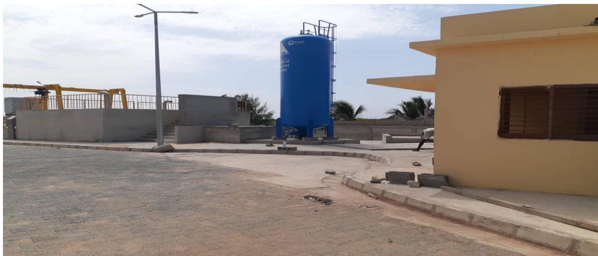
Station d'épuration de Mbeubeuss de la commune de Keur Massar réalisée par l'ADM dans le cadre du PROGEPI
