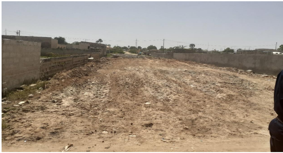
Photo : Commune de Fatick, site du tribunal de Fatick, opération de remblayage de point bas pour rétablir les passages inondés
