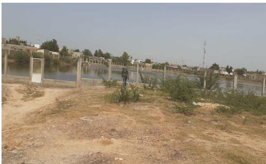
Photo : Grand bassin de Peulga, point de collecte des eaux pluviales, à l'origine il était une mare d'eaux, elle a été transformée en bassin de rétention par l'ONAS dans le cadre du PDLI
